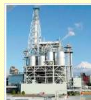
低圧光熱炉 (ボイラ) (CFB)
