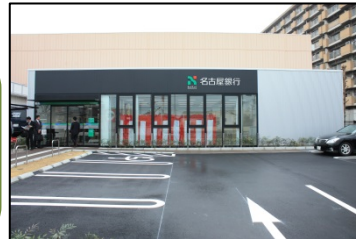
＜木場支店外観写真＞
