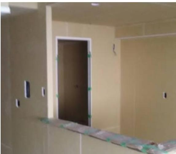
ボード貼り工事とは軽天工事で組み立てた骨組み（下地）に、断熱材などを入れてから石膏製のボード（壁）を張る工事である。
