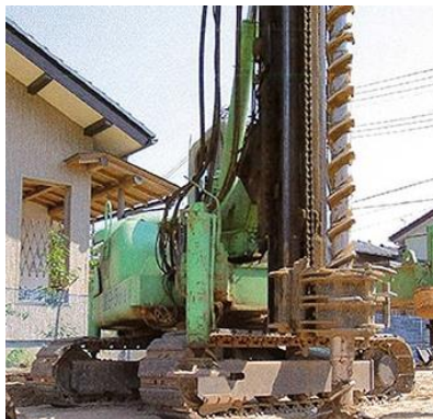
施工時の様子
