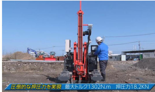
当社が導入したスーパーナロー工法施工機
