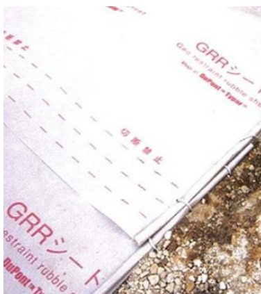
施工時の様子
