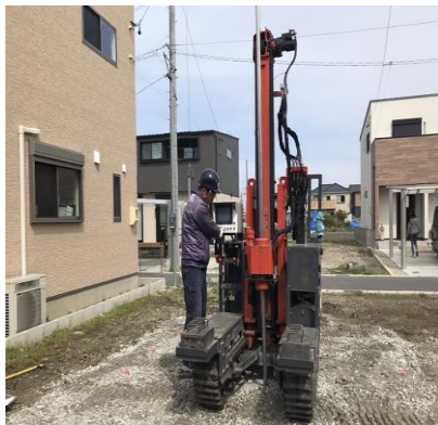
施工時の様子
