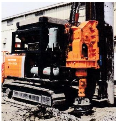
施工時の様子
