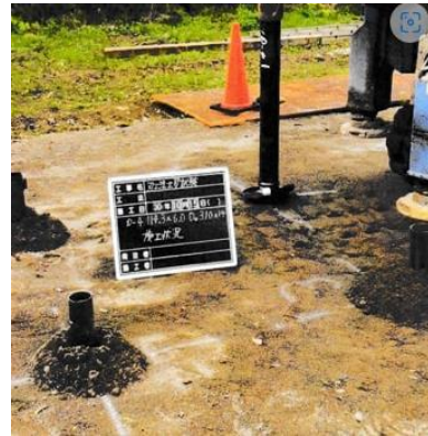
杭打終了時の様子
