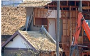
木造建築解体
