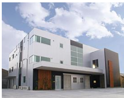
本社・第一工場
