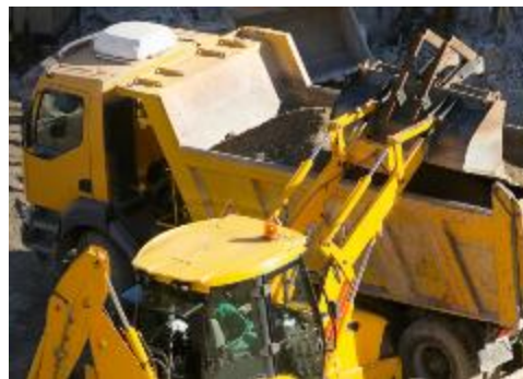
土砂運搬の様子
