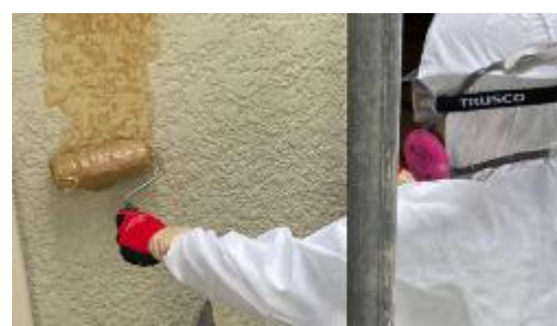
アスベスト除去工事
