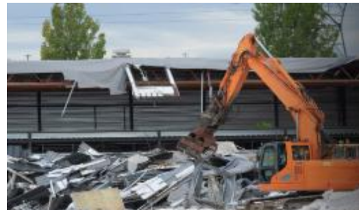
鉄骨倉庫解体
