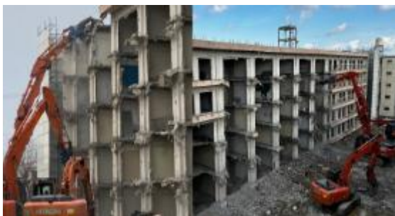
大型ビル解体
