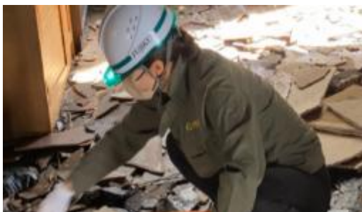
内装工事・解体
