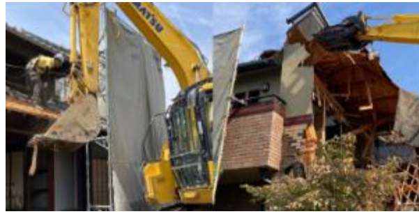
木造建築の解体
