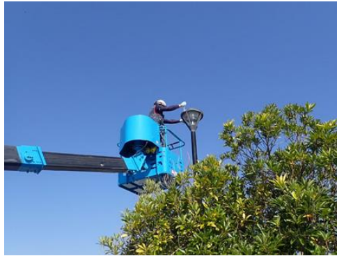
街灯電気工事
